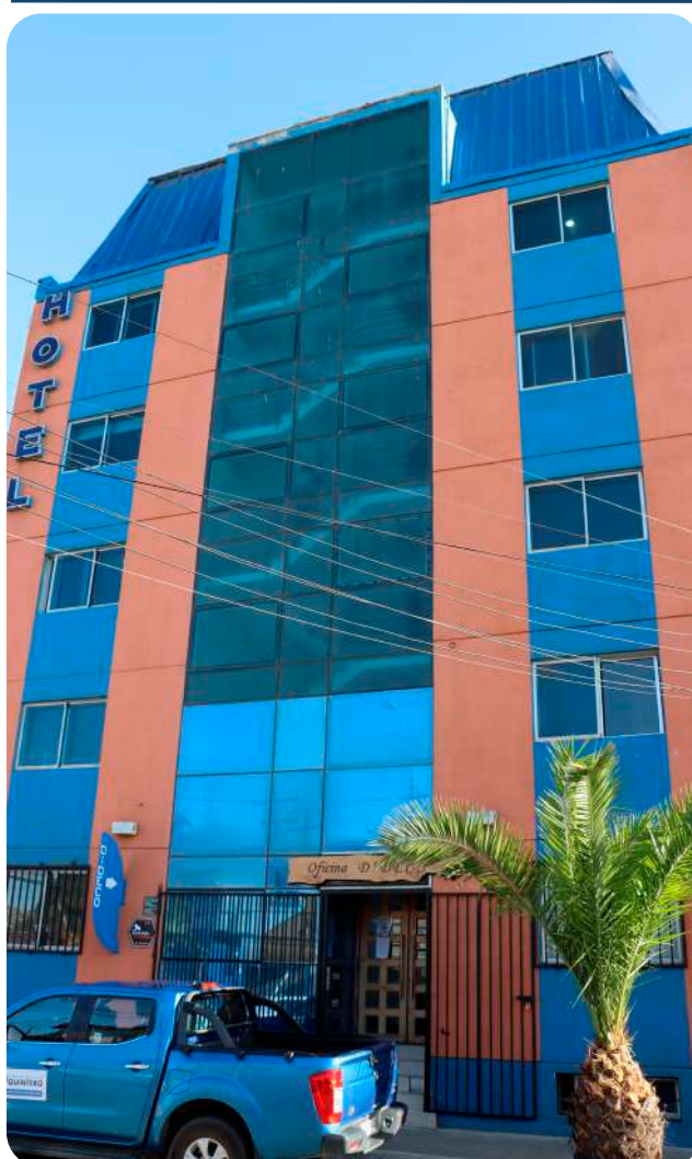
Edificio de DIDECO ubicado en calle Cochrane #180, Quintero.
